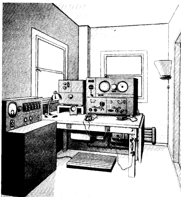
Abb. 2: Inneres des Bedienungshauses mit Peiltisch und Schalttafel
